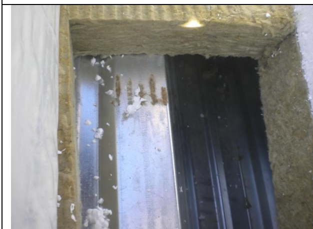
På den anden del af taget er det opbygget som et traditionelt varmt tag på en ståltrapezplade.
