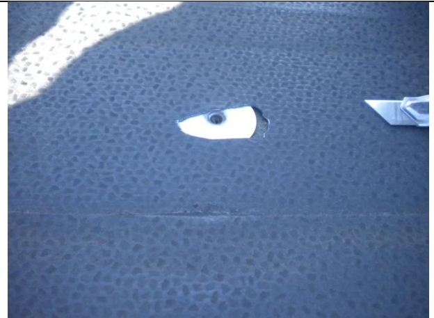
Teleskopskiverne til fastgørelse af tagfolien sidder løst
