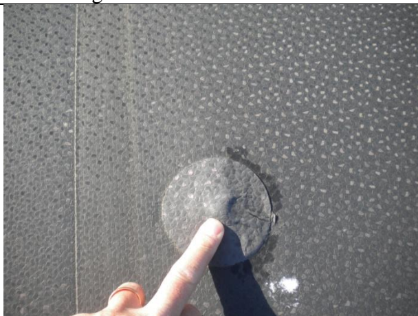
Tagskruen har været trykket op i teleskopet og har trykket på tagfolien.
