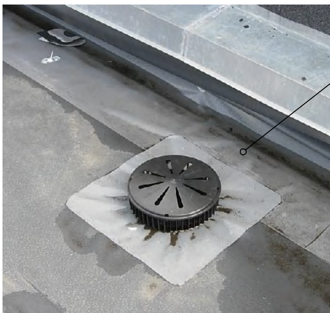
Foto af tagbrønd igennem SkanDek.
