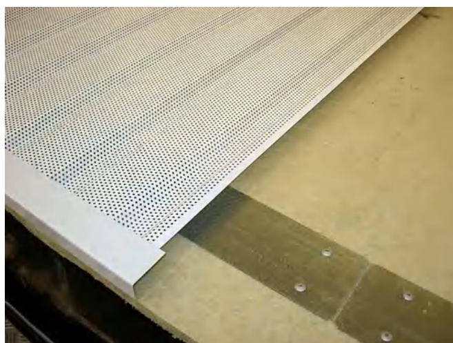
Foto af fuldperf. ståltrapezplade og TF-fasthold.
